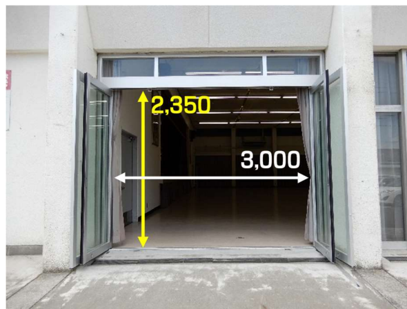
搬入口④（P.3 参照）を開けた時
