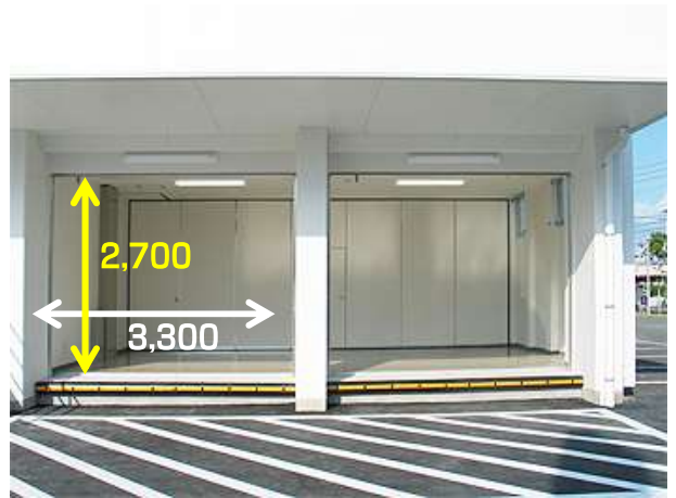
外から搬入口を撮影 (H2,700×W3,300)
